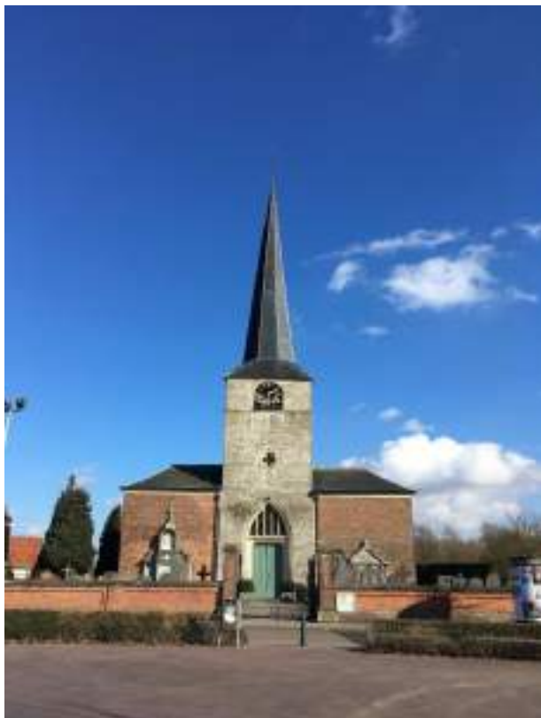
Afb 5: Extérieur, voorgevel (©stad Mechelen dienst MZ, 2017)
