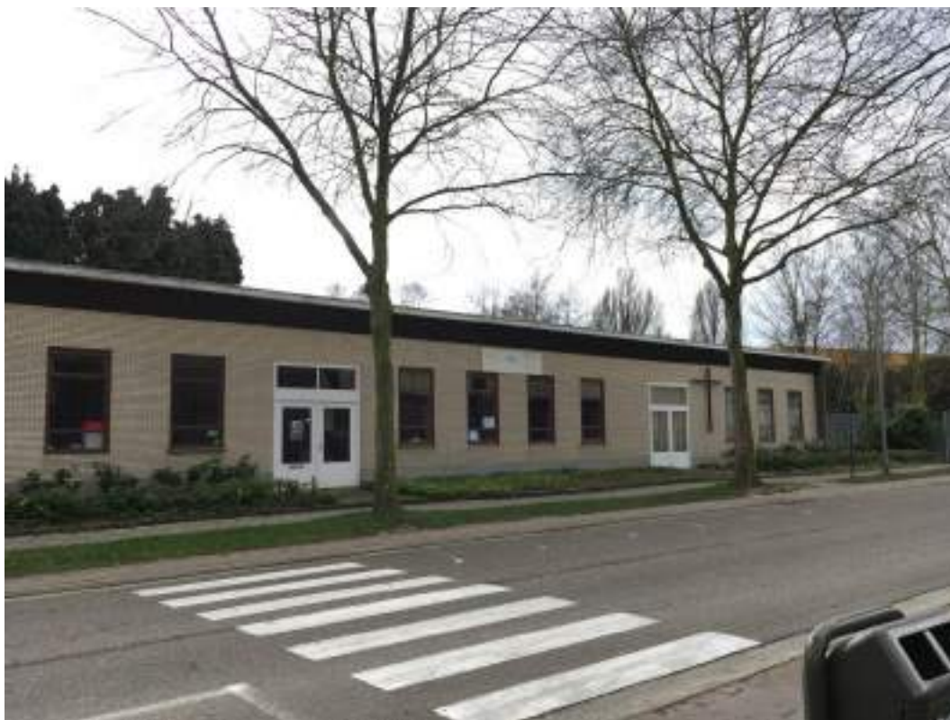
Afb 6: Extérieur, zicht op de voorgevel (©stad Mechelen dienst MZ, 2017)
