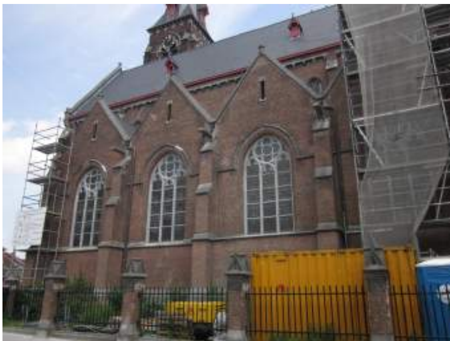
Afb 7 : Extérieur, zicht op de zuidgevel (©stad Mechelen dienst MZ, 2015)
