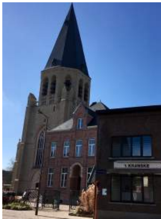
Afb 6: Extérieur, zicht op de voorgevel, pastorie en parochiecentrum (©stad Mechelen dienst MZ, 2017)
