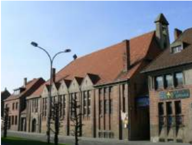
Afb 5: Extérieur, zicht op de voorgevel (©stad Mechelen dienst MZ, 2008)
