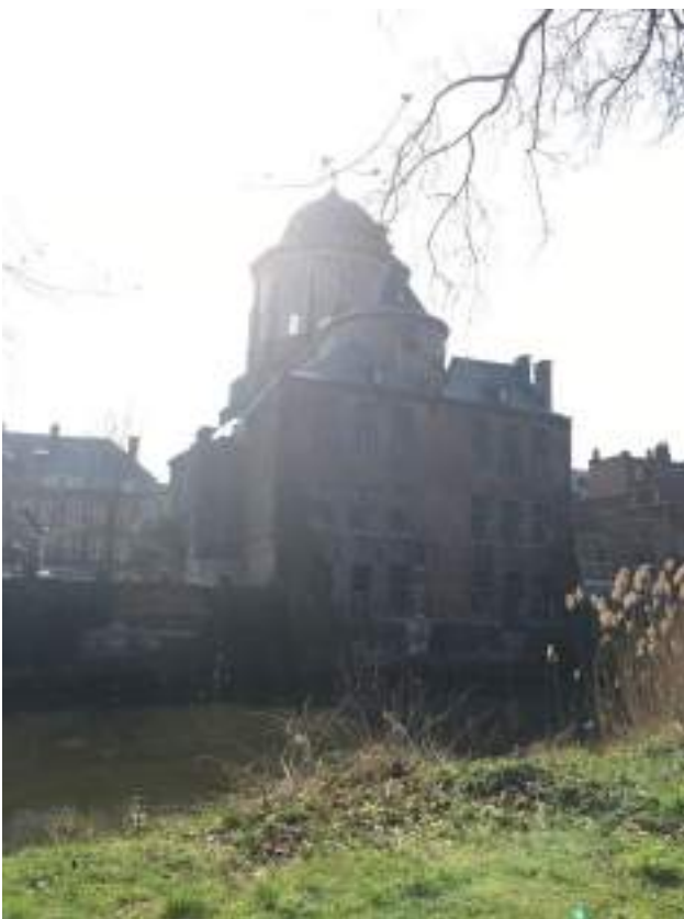
Afb 6: Extérieur, zicht op de noordgevel (©stad Mechelen dienst MZ, 2017)
