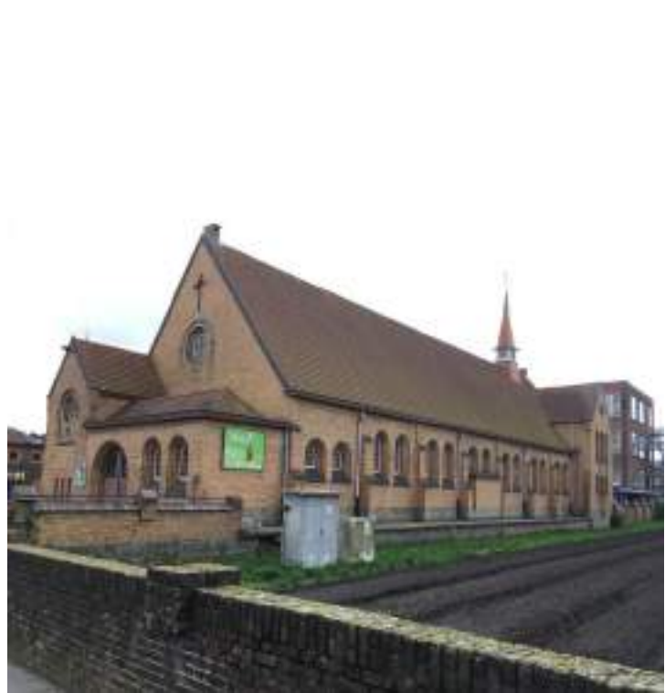
Afb 6: Extérieur, zicht op voorgevel en noordgevel (@stad Mechelen dienst MZ, 2017)
