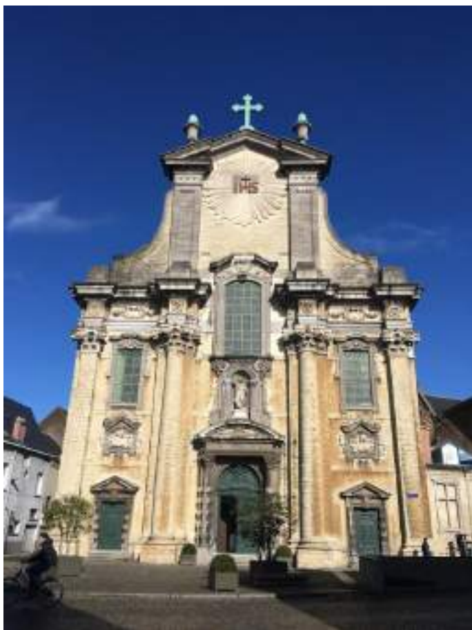
Afb 5: Extérieur, zicht op de voorgevel (©stad Mechelen dienst MZ, 2017)
