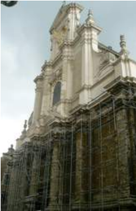
Afb 5: Extérieur, zicht op de voorgevel (©stad Mechelen dienst MZ, 2011)
