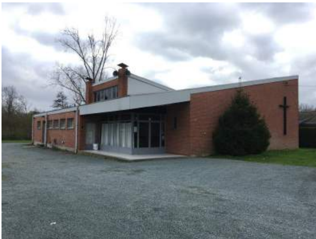
Afb 5: Extérieur, zicht op voorgevel en inkomportaal (©stad Mechelen dienst MZ, 2017)
