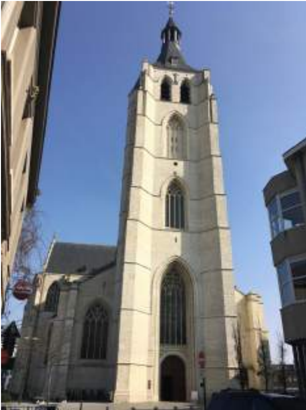
Afb 5: Extérieur, zicht op westgevel (©stad Mechelen dienst MZ, 2017)
