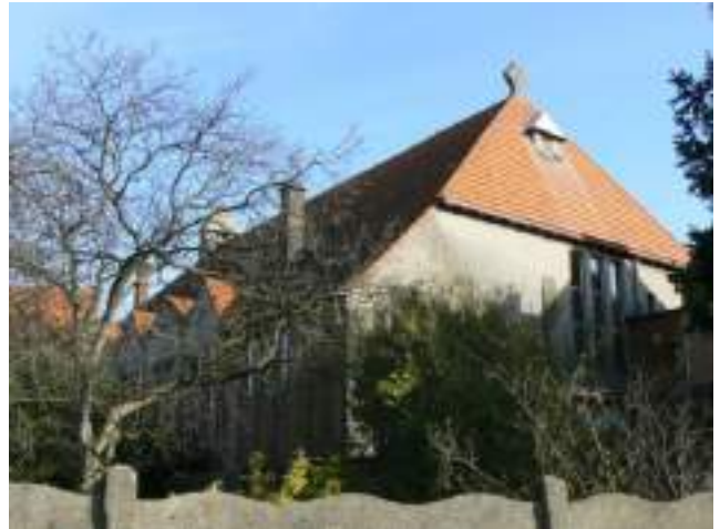
Afb 6: Extérieur, zicht op de voorgevel (©stad Mechelen dienst MZ, 2008)
