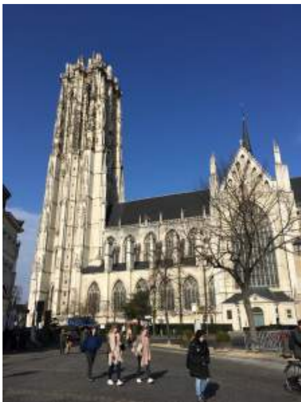
Afb 5: Extérieur, zicht op de zuidgevel (©stad Mechelen dienst MZ, 2017)
