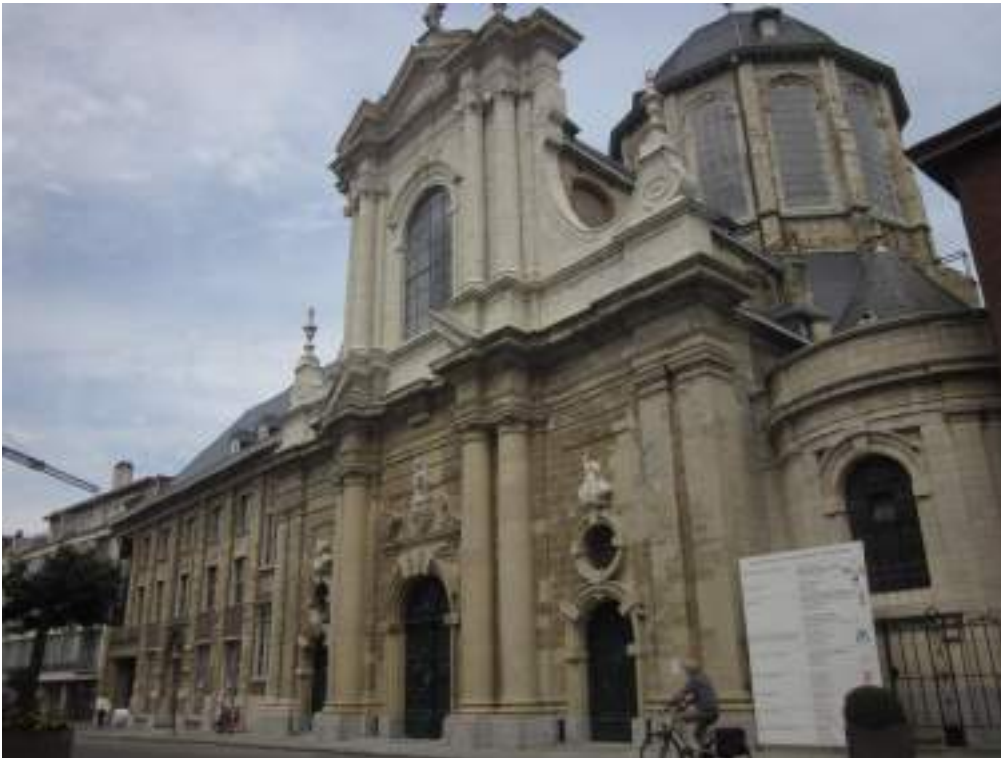
Afb 5: Extérieur, zicht op de voorgevel (©stad Mechelen dienst MZ, 2016)
