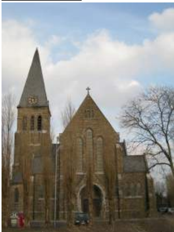
Afb. 5: Extérieur, zicht op westgevel (@stad Mechelen dienst MZ, 2008)
