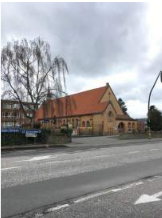
Afb 7: Extérieur, zicht op voorgevel en zuidgevel (@stad Mechelen dienst MZ, 2017)
