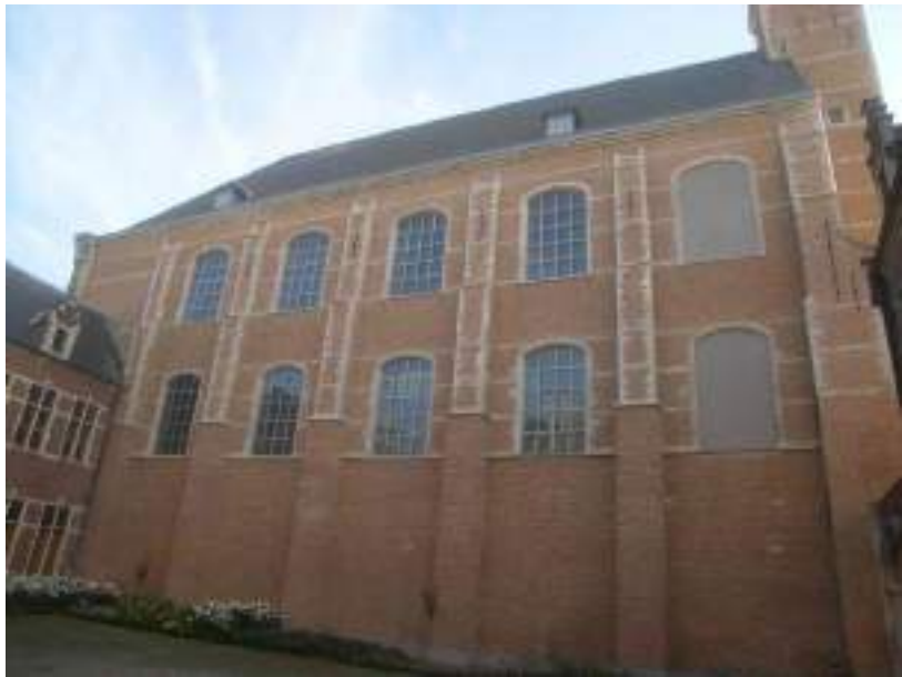
Afb. 8: exterieur, zicht noordgevel (©stad Mechelen dienst MZ, 2013)
