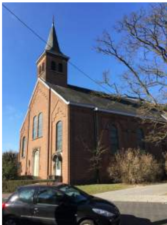
Afb 6: Extérieur, zicht op voor- en zijgevel (©stad Mechelen dienst MZ, 2017)
