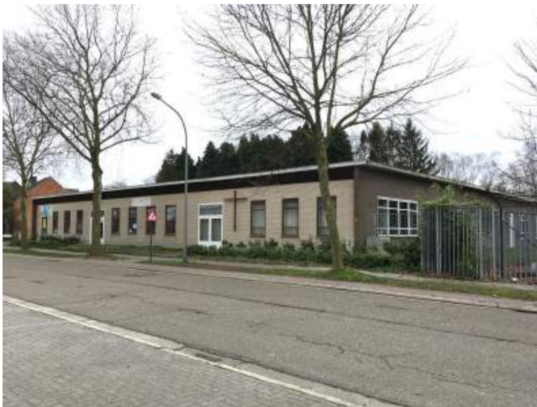
Afb 5: Extérieur, zicht op de voorgevel (©stad Mechelen dienst MZ, 2017)
