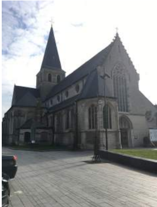
Afb 6: Extérieur, zicht op west- en noordgevel (©stad Mechelen dienst MZ, 2017)
