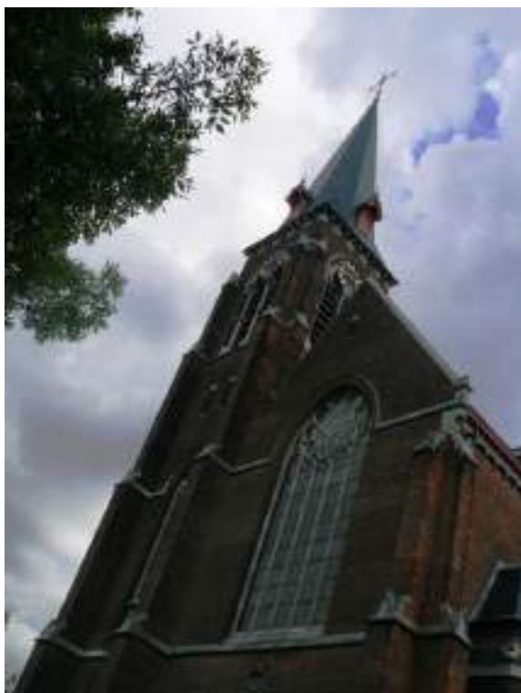
Afb 5: Extérieur, zicht op westgevel (©stad Mechelen dienst MZ, 2007)
