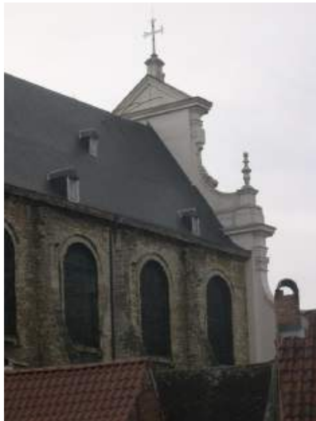
Afb 8: Extérieur, zicht noordwestgevel (©stad Mechelen dienst MZ, 2011)
